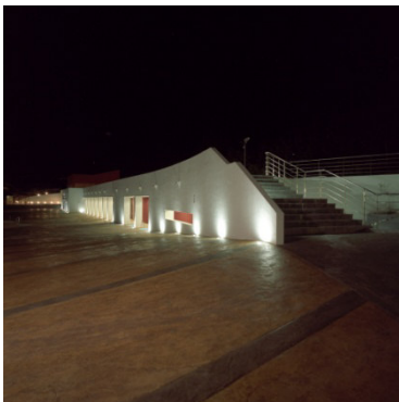
Edificio principale Parco acquatico
