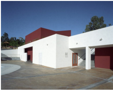
Corpo esistente inglobato nell'edificio principale Parco acquatico
